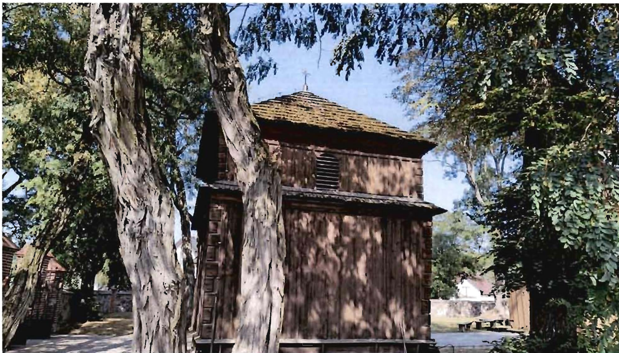
FOT. 7 Widok dzwonnicy od strony południowej
