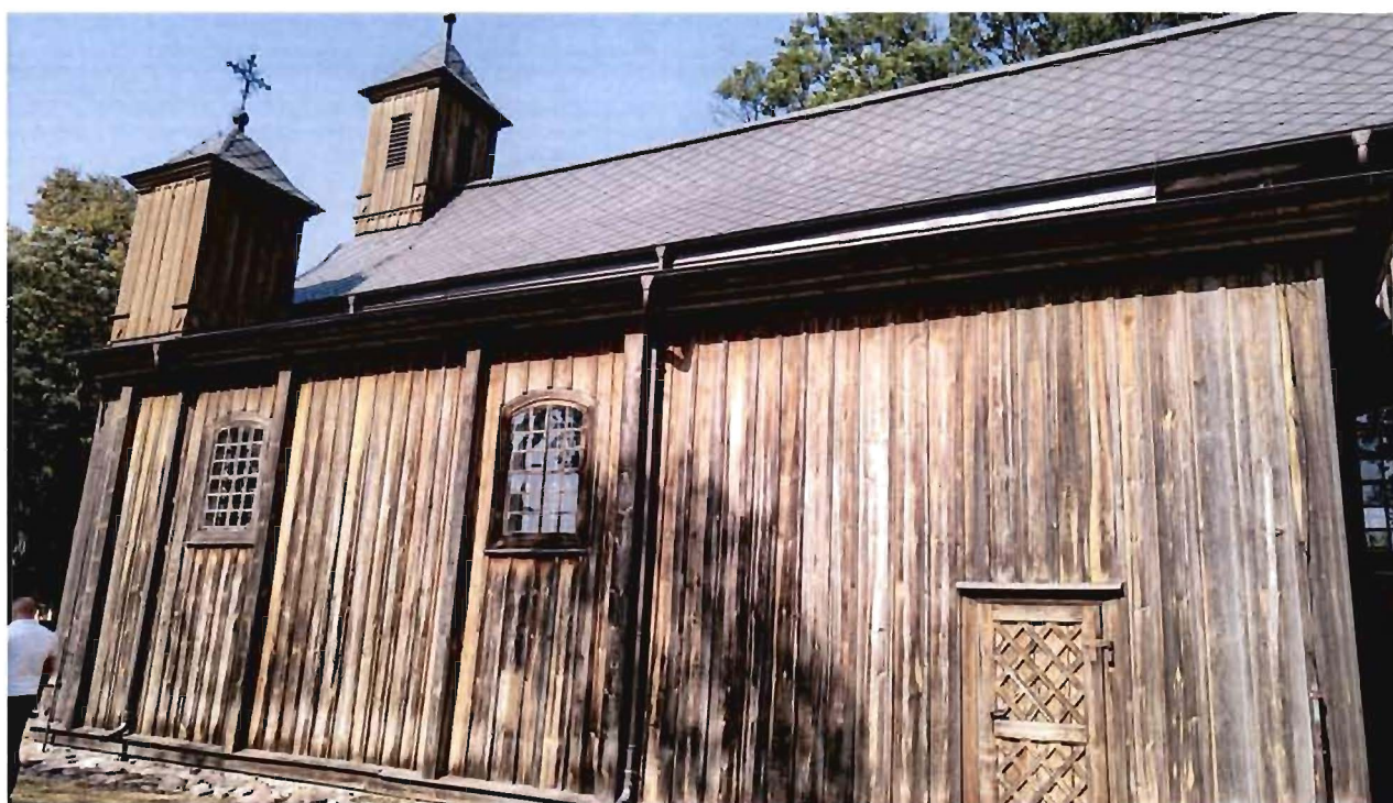
FOT. 6 Widok kościoła od strony południowej
