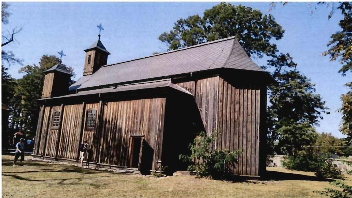
FOT. 1 Widok kościoła od strony południowej
