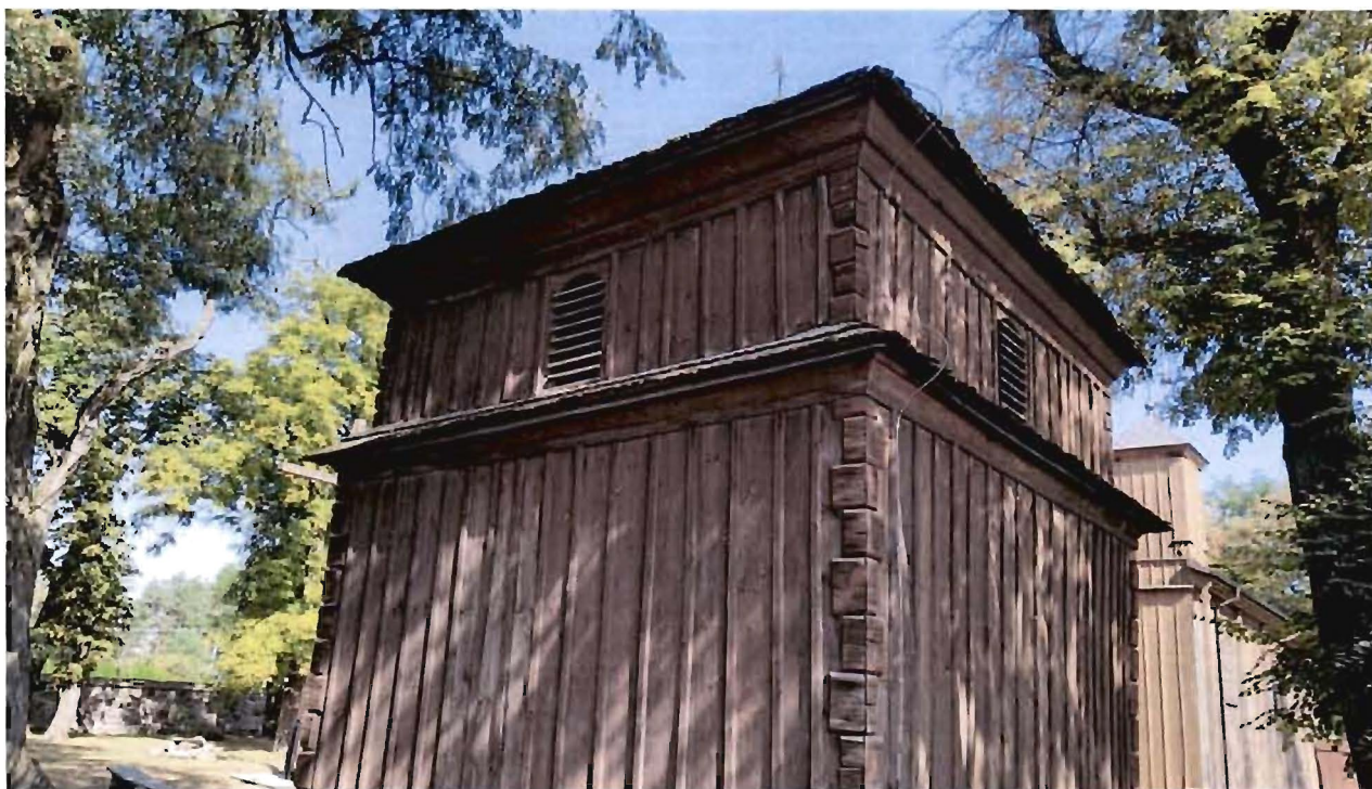
FOT. 8 Widok dzwonnicy od strony zachodniej
