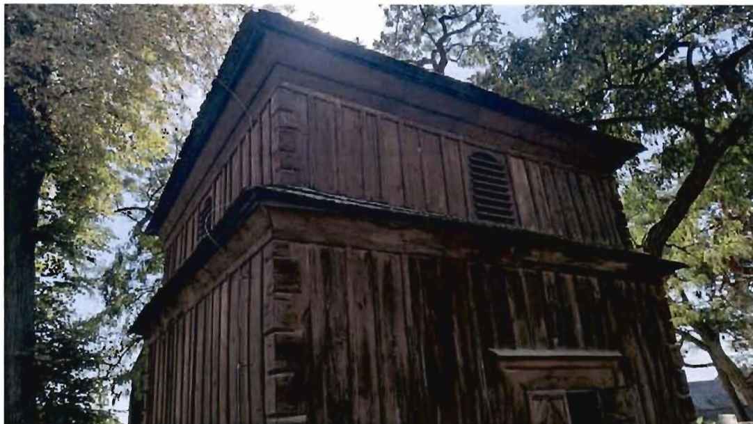
FOT. 11 Widok dzwonnicy od strony północnej
